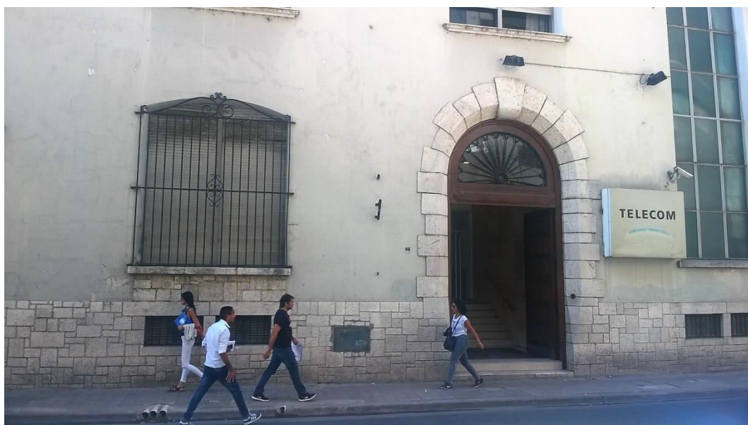
Edificio Córdoba Centro
