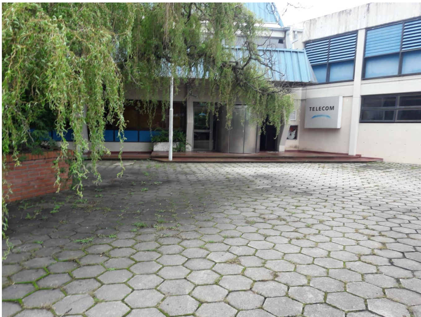
Vista de ingreso a la planta
