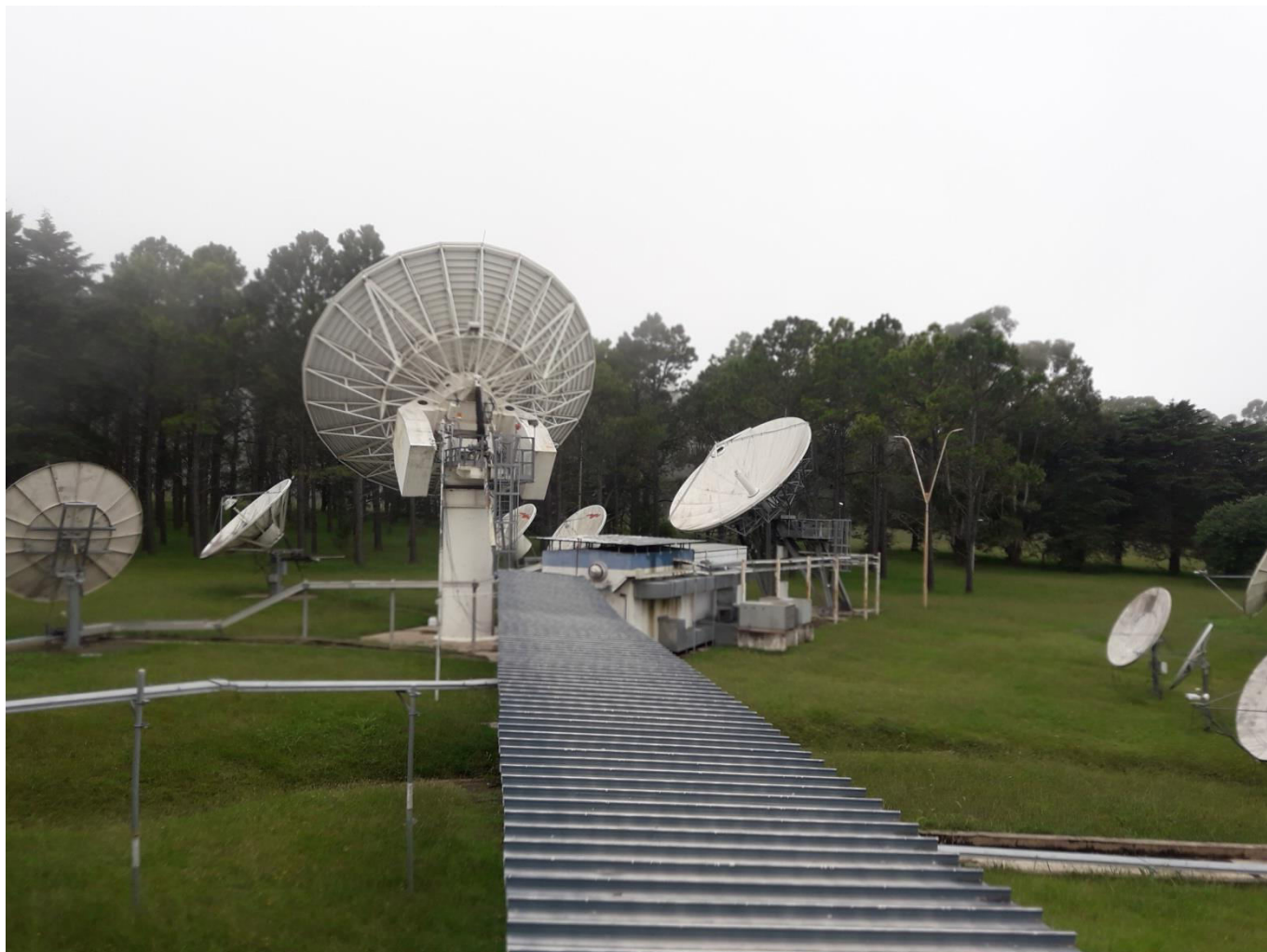
Sendero que comunica al parque de antenas
