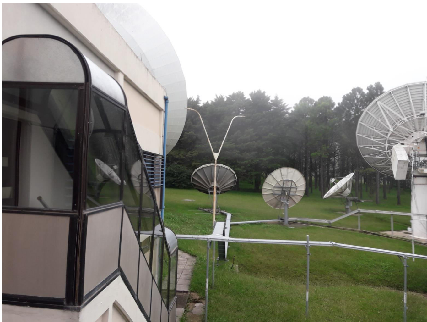
Parque de antenas
