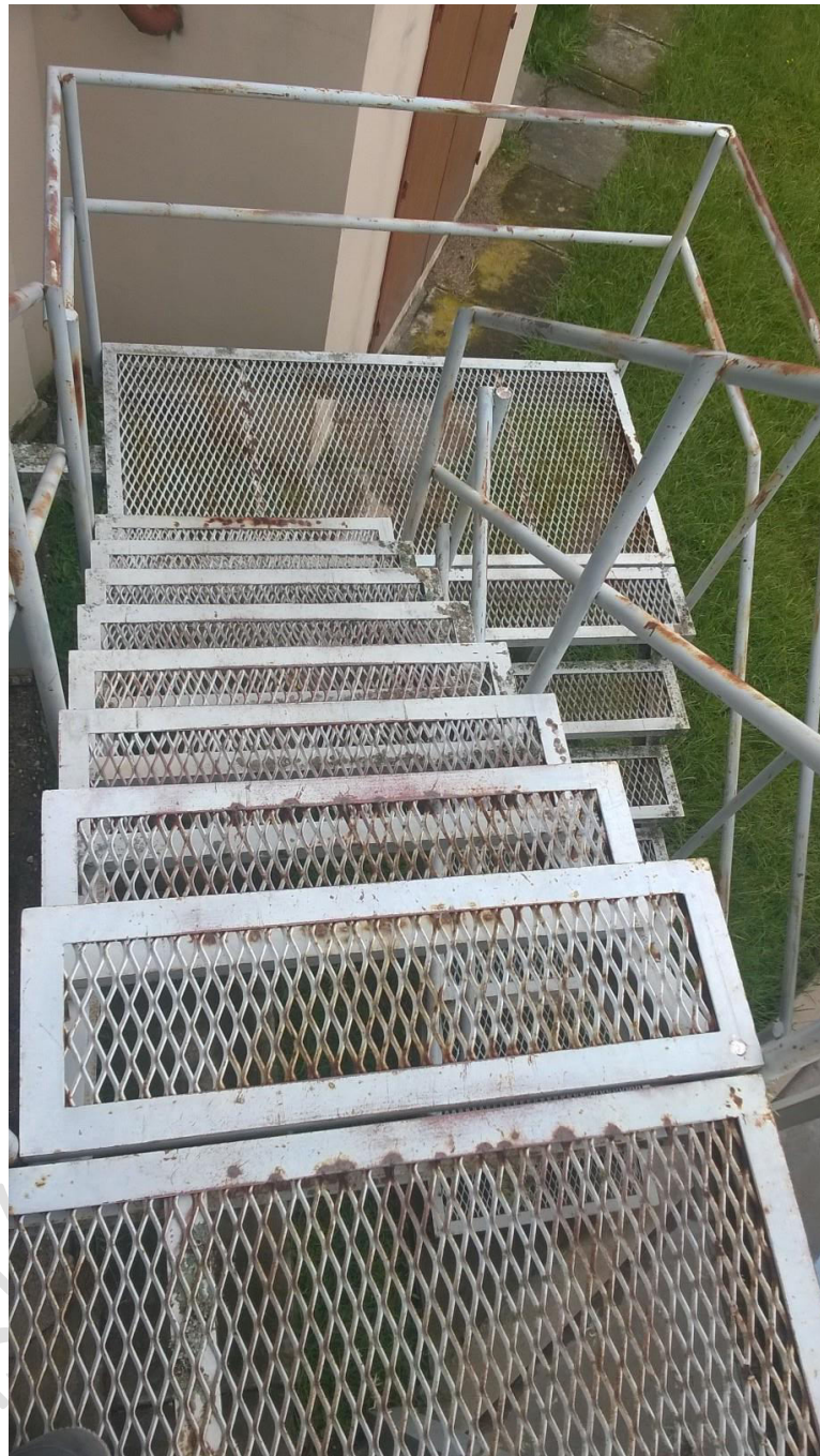
Salida de evacuación de la sala de consolas
