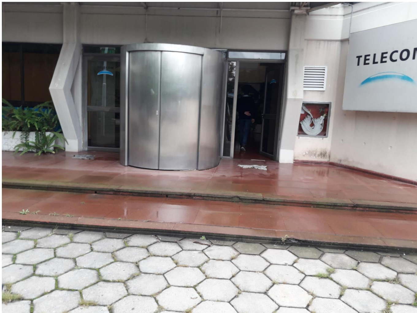
Vista de ingreso a la planta
