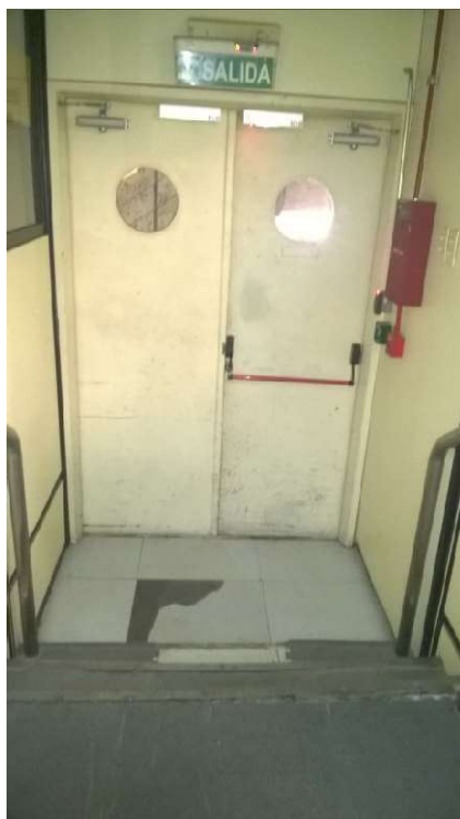
Salida de emergencia lado industria piso 1
