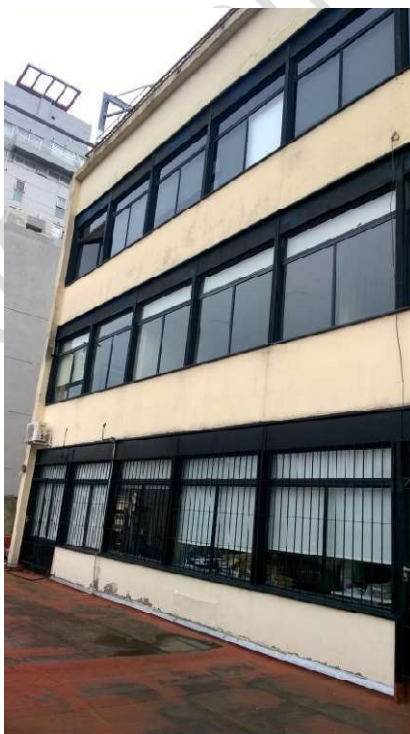
Vista pisos 4, 5 y 6 lado industrial
