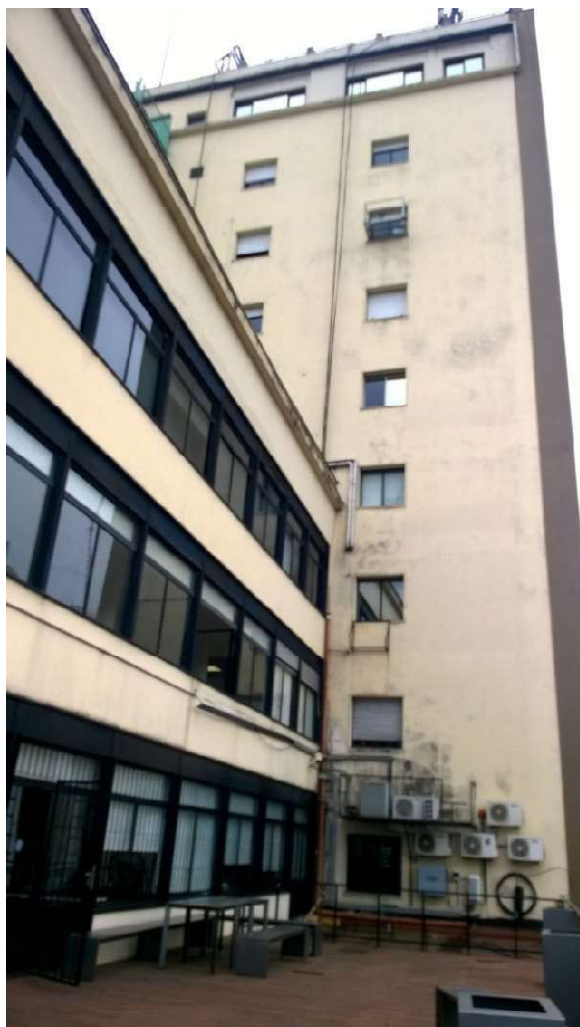
Vista pisos 4, 5 y 6 lado industrial y lado torre
