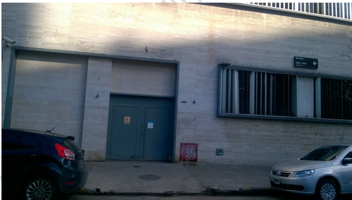
Entrada secundaria y salida de evacuación, Dorrego 2540
