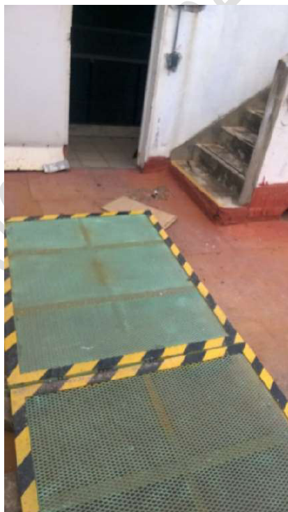
Ingreso a la escalera de emergencia (piso 7)
