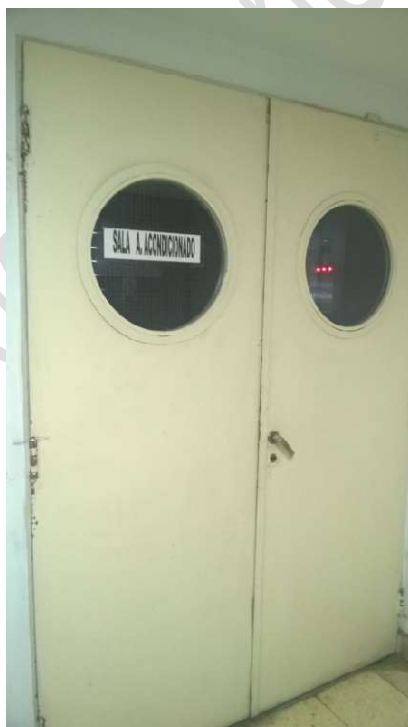
Sala de AA piso 2
