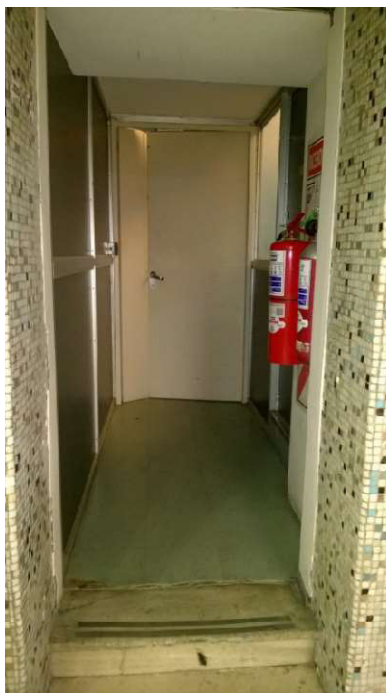
Entrada lado industrial planta baja
