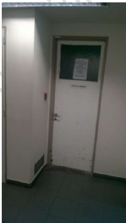
Acceso a la azotea piso 12
