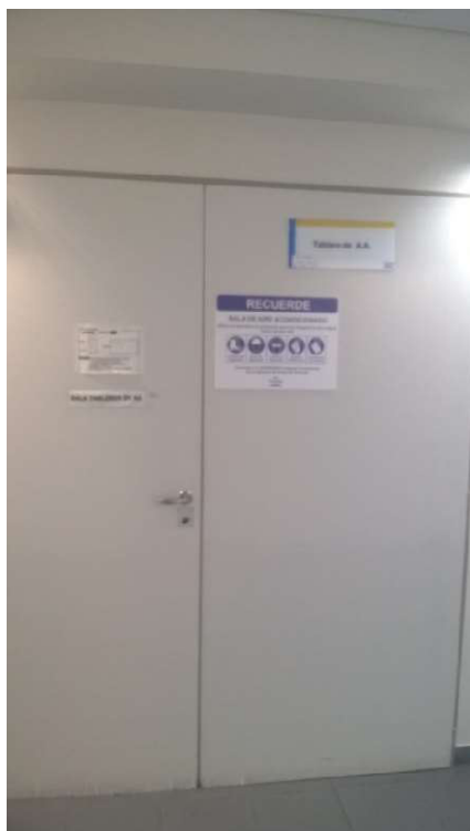
Sala Tableros de AA piso 12
