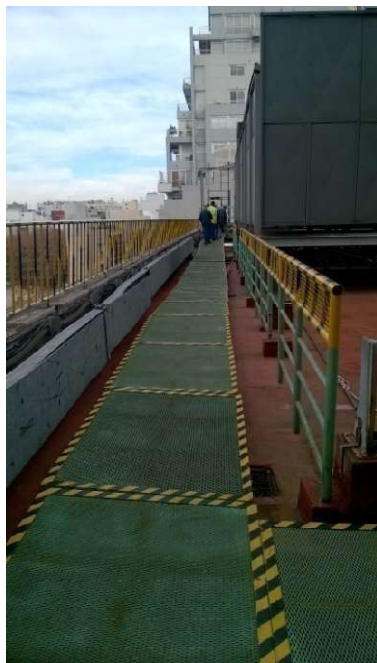
Salida de emergencia externa sobre azotea (piso 7)
