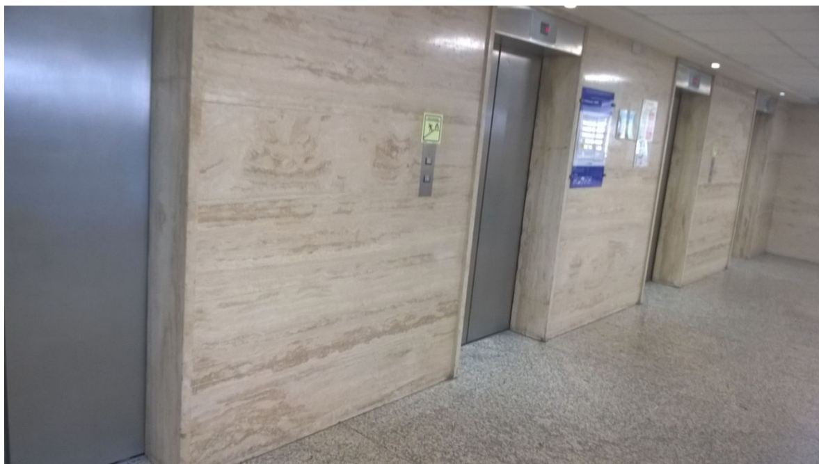
Hall de ascensores piso 4
