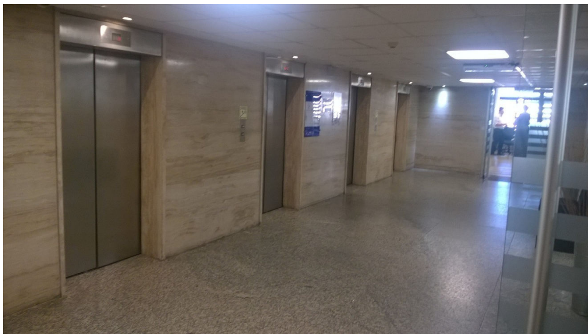
Hall de ascensores piso 2
