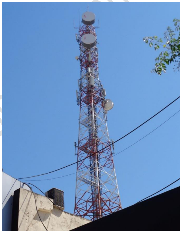
Vista la estructura soporte de antenas
