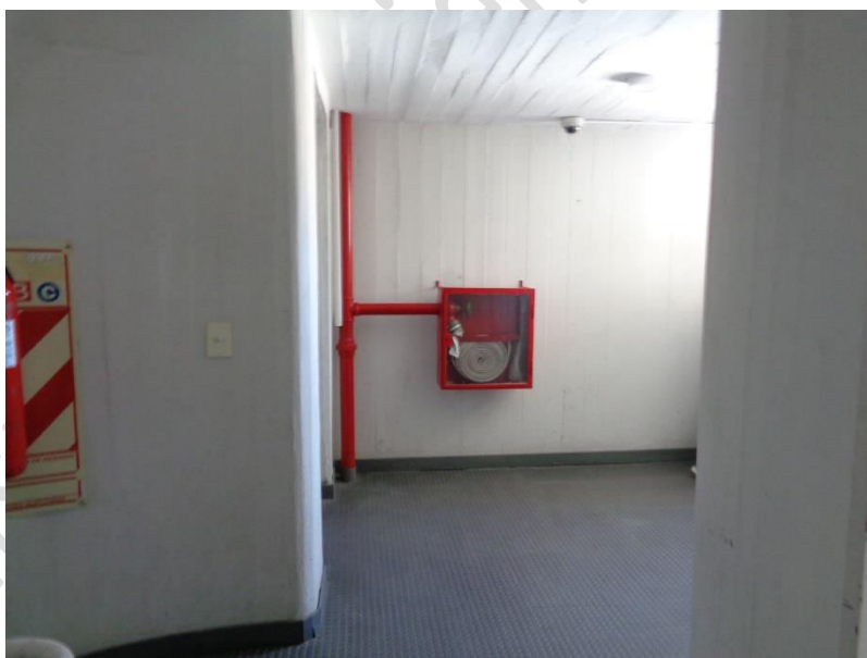
Escalera de emergencia lado contrafrente con acceso al ascensor
