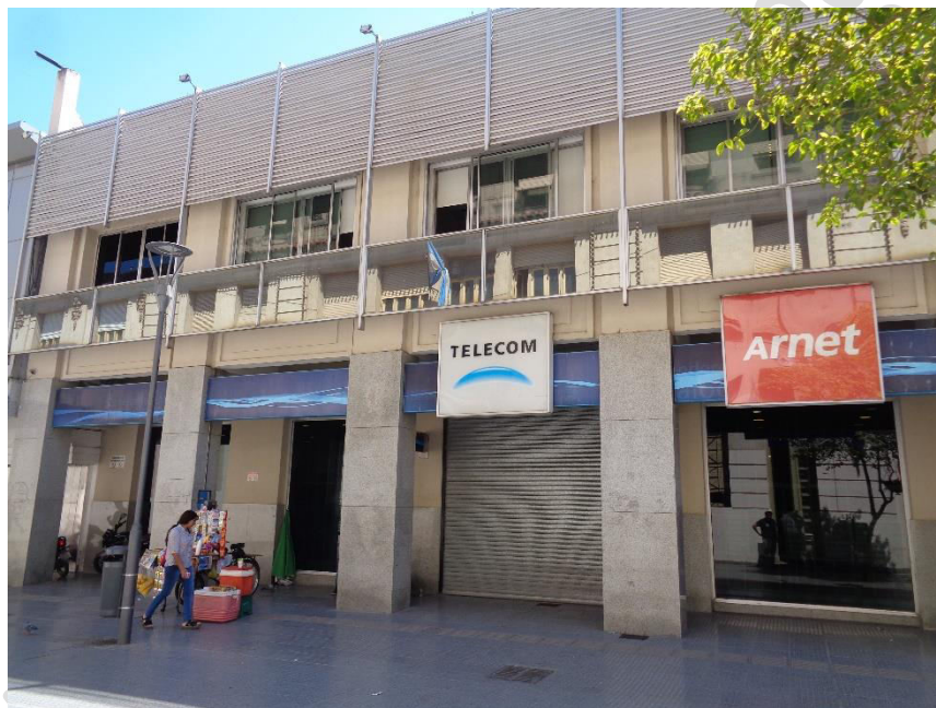
Vista del ingreso a las oficinas comerciales y central
