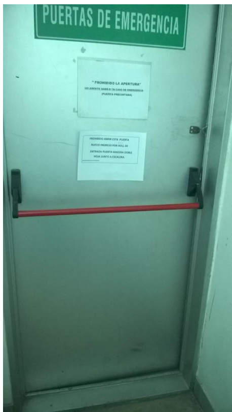
Vía de escape (Izq) Puerta trabada con precinto en planta baja – (Der) Puerta en planta alta
