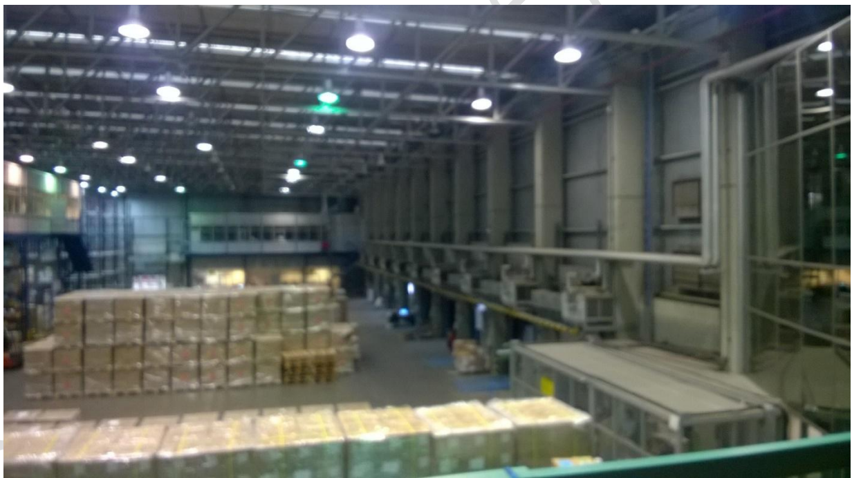
Vista del interior de la nave desde la planta alta
