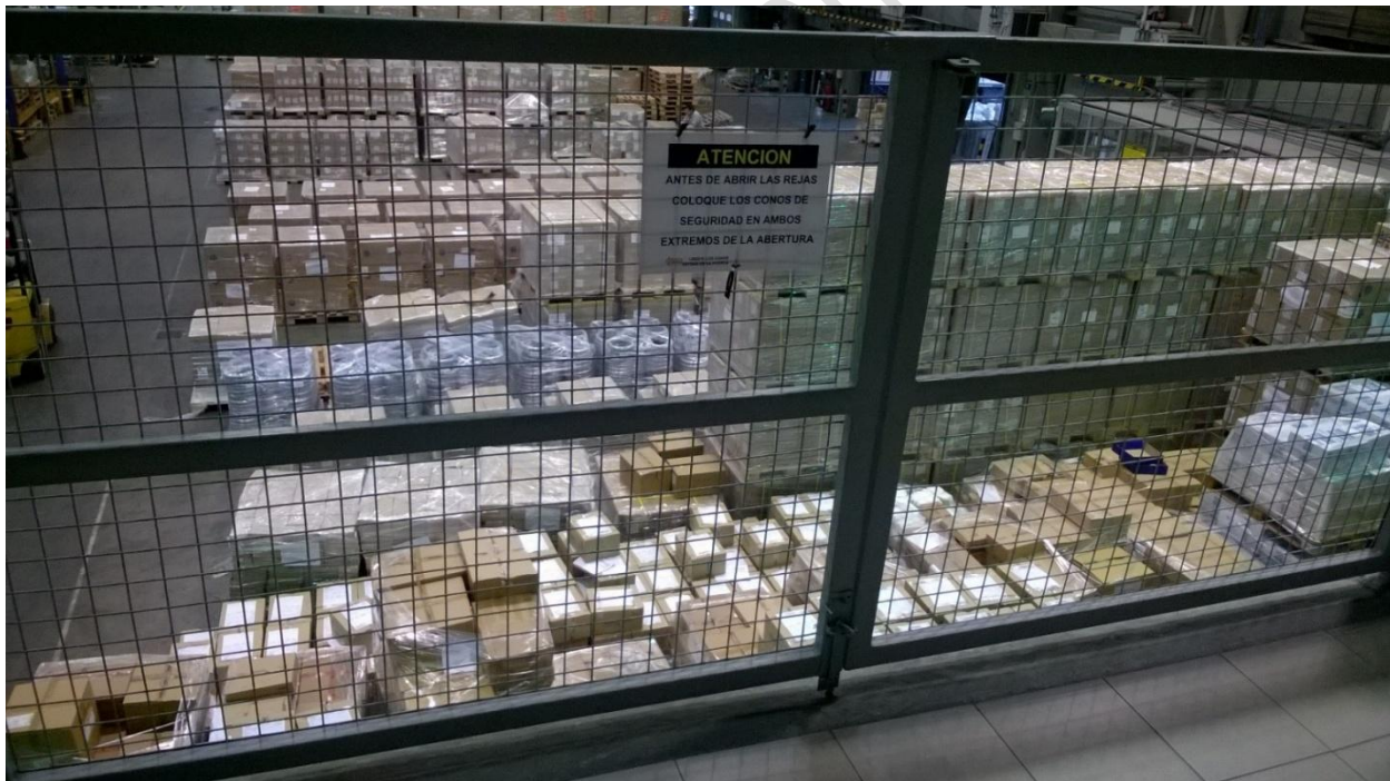
Barandas móviles para acceso de materiales a la planta alta
