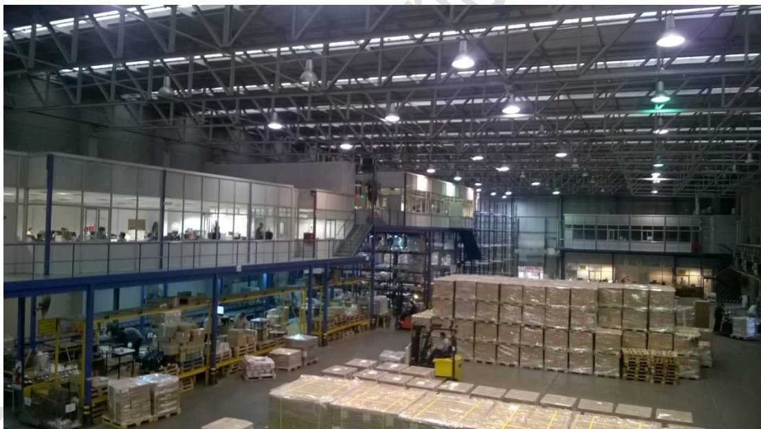
Vista del interior de la nave desde la planta alta
