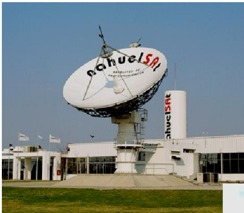
Telepuerto Nahuel Sat
