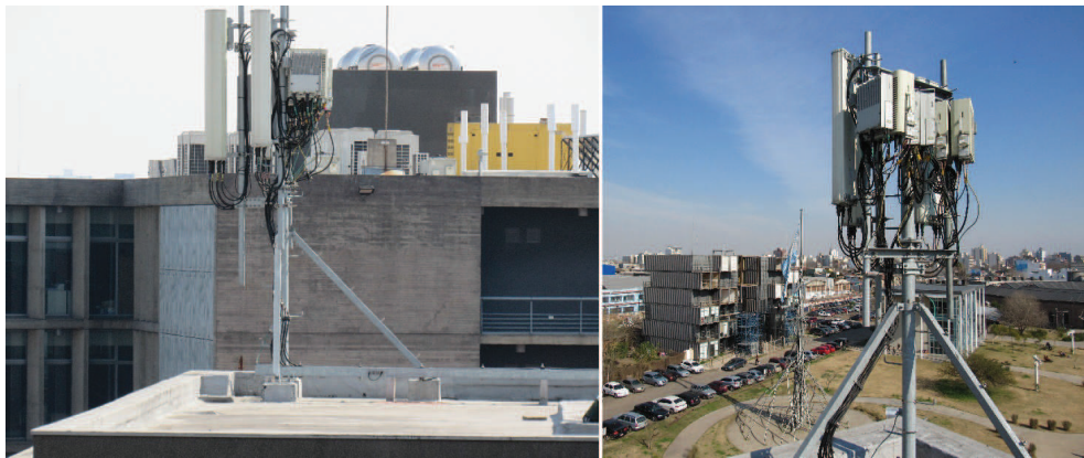
Figura 7.13: Fotos de la Instalación del emplazamiento sector C
