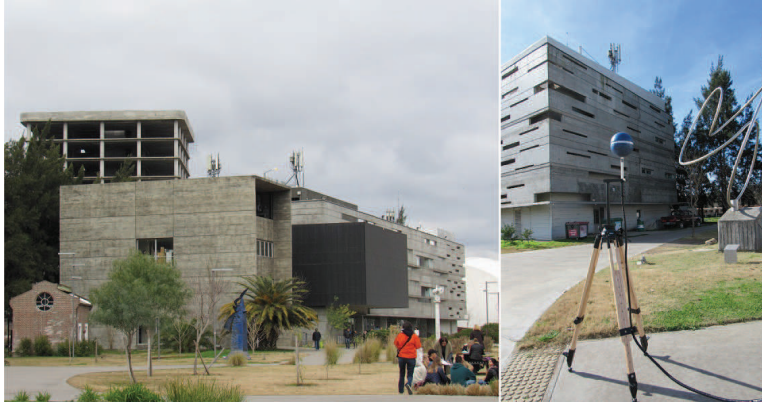
Figura 7.12: Fotos del sitio de medición mostrando los sistemas irradiantes
